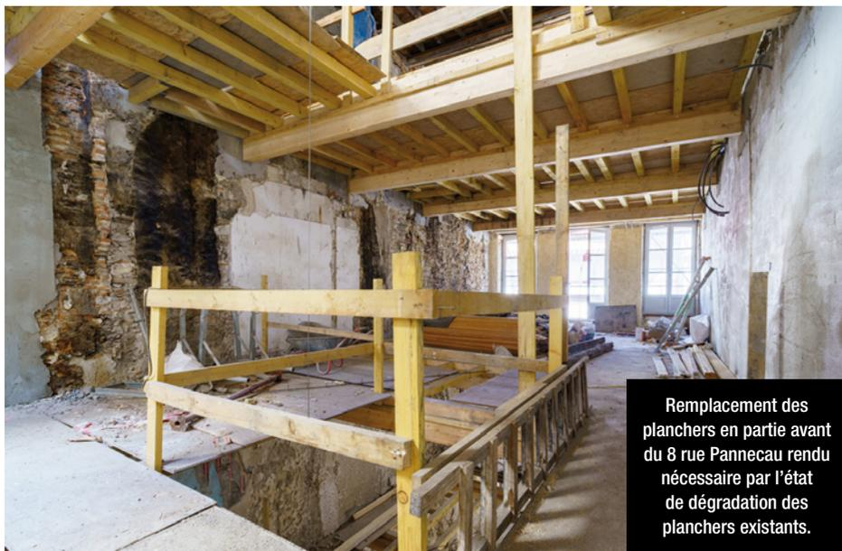
Remplacement des planchers en partie avant du 8 rue Panneau rendu nécessaire par l'état de dégradation des planchers existants.
