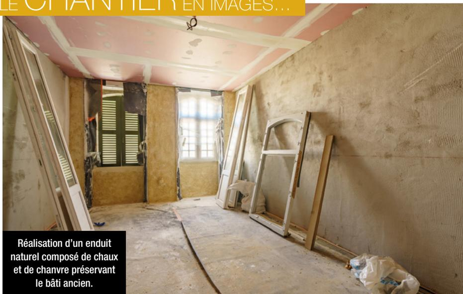
Réalisation d'un enduit naturel composé de chaux et de chanvre préservant le bâti ancien.
