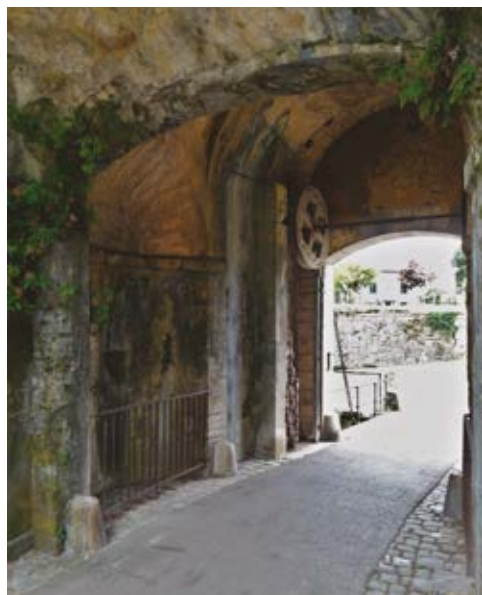
Système de pont-levis à la Poncelet à la porte de Mousserolles.
